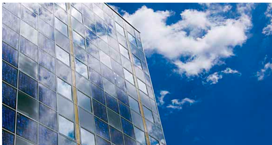
Design und Funktion: Eine Solarfassade wertet Gebäude auf.
