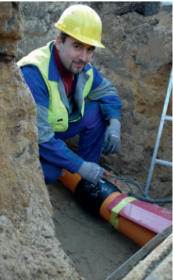
Bei unseren Monteuren ist das Leitungsnetz in guten Händen – so wie hier bei EWV-Mitarbeiter Sebastian Hess.
