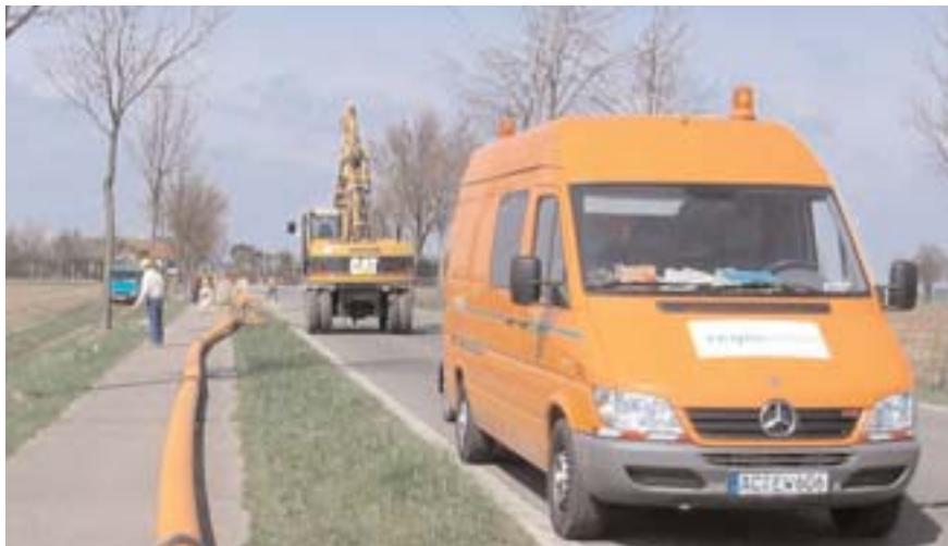
Investitionen in die Versorgungssicherheit: Hier werden neue Erdgasleitungen verlegt.
